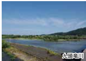
九頭竜川 鳴鹿大堰
