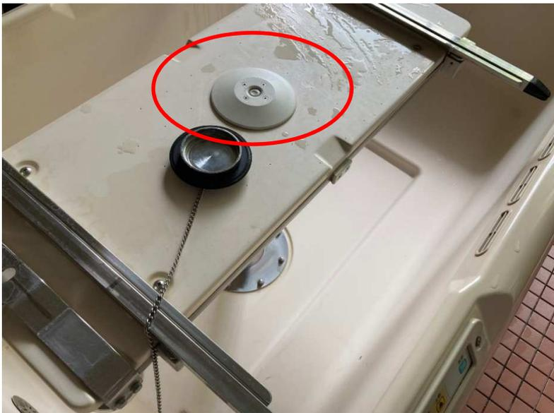
経年劣化でセンサーが故障して昇降器具が稼働しなくなった。
