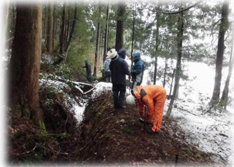
電気柵設置作業
